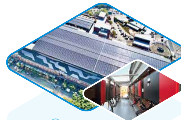
台湾建国市场 1.5Mw光伏发电项目
