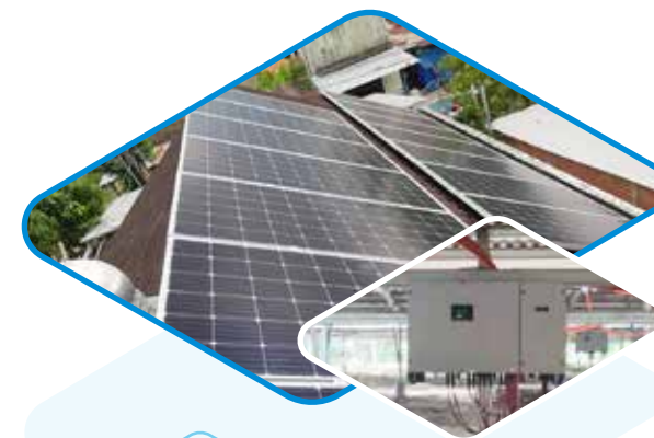
越南 200Mw光伏发电项目
