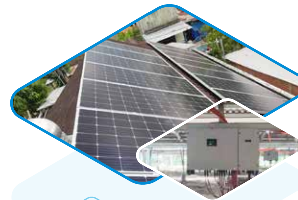
越南 200Mw光伏发电项目
