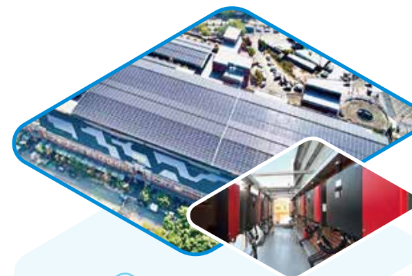
台湾建国市场 1.5Mw光伏发电项目
